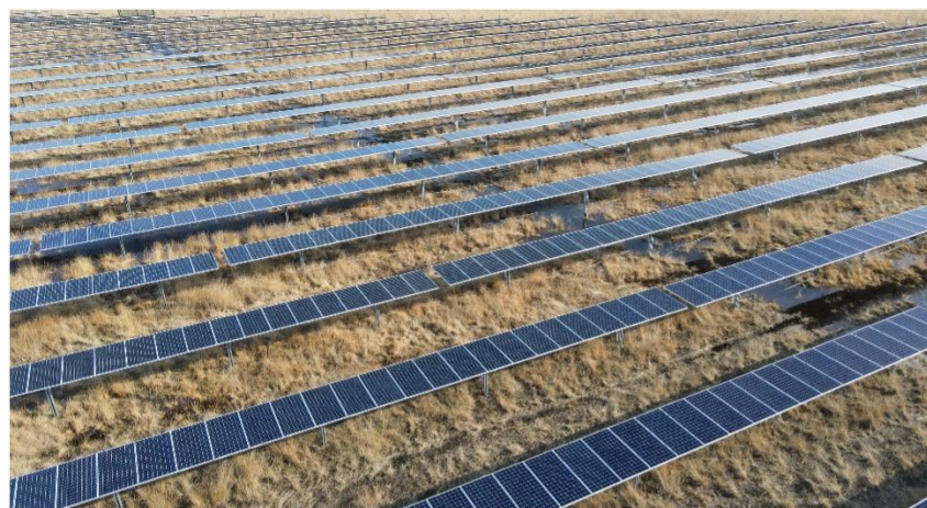
Chantier du parc photovoltaïque de Mézos-Pinvert (40)
